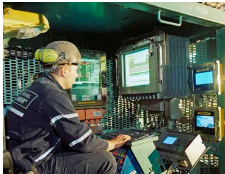
Подземная станция управления
